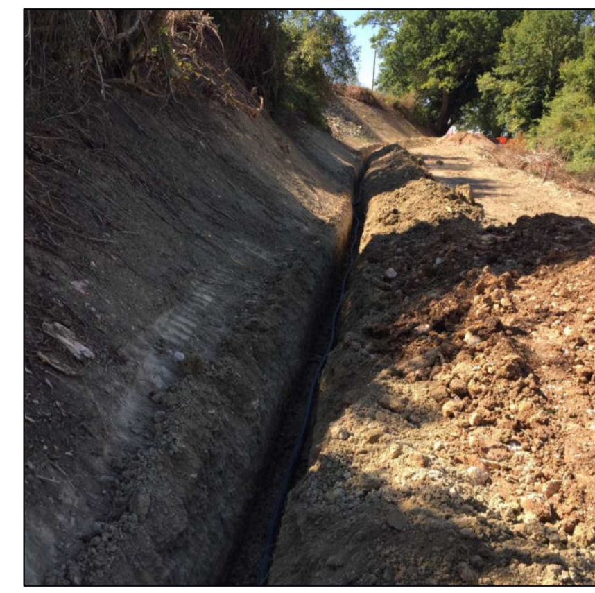
FOTO 03 stesura della linea di acquedotto sostitutiva, secondo le indicazioni dell'ente gestore SII lungo il tracciato stradale ripristinato
