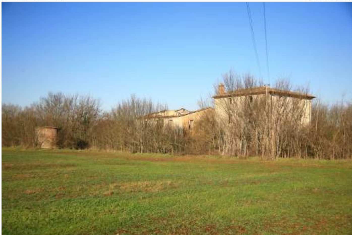
Figura 6. Vista degli edifici presenti nell'area
